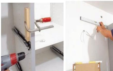
Montieren Sie zunächst die Unterschränke und richten Sie diese mit einer Wasserwaage aus. Drehen Sie die Küchenfüße ca. 10mm raus, so dass Sie ca. einen Abstand von 155mm von der Unterkante Unterboden zum Fußboden haben.
